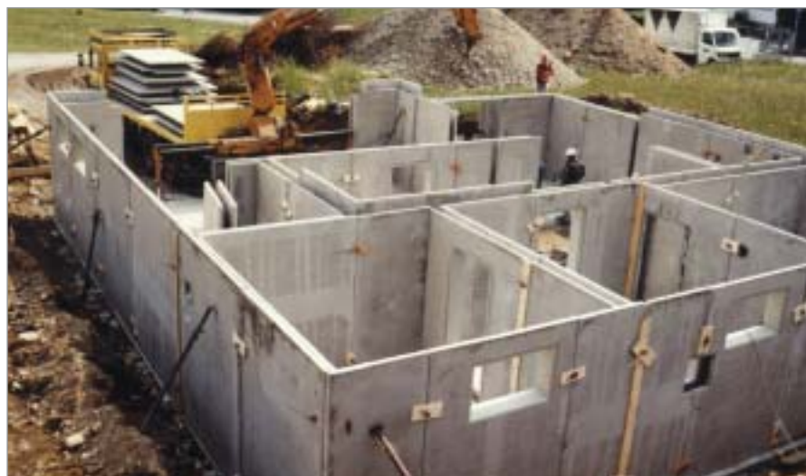
Eine Wohnhaus entsteht unter Verwendung von vorgefertigten Doppelwänden. Der nächste Schritt ist die Montage der ebenfalls vorproduzierten Deckenelemente
