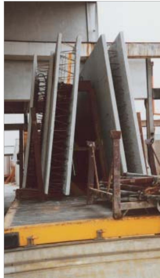
Fertige Doppelwände auf dem Weg zur Baustelle. Nach der Montage werden sie mit Ortbeton gefüllt
