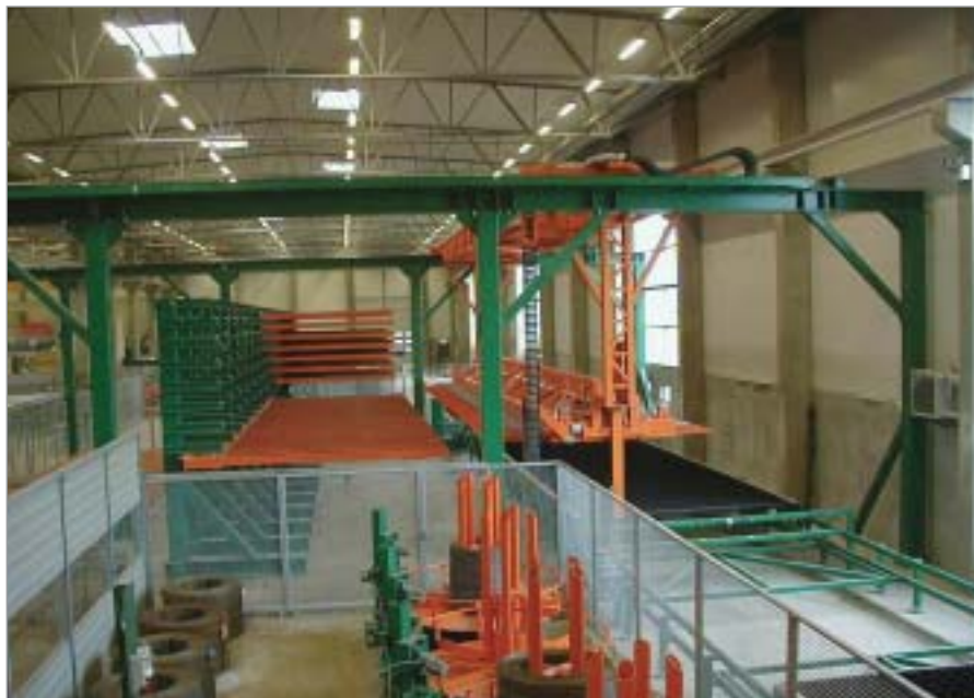
Die Mattenschweißanlage und das Mattenlager
