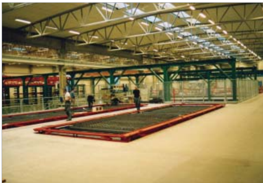
Ergänzung der Bewehrung
