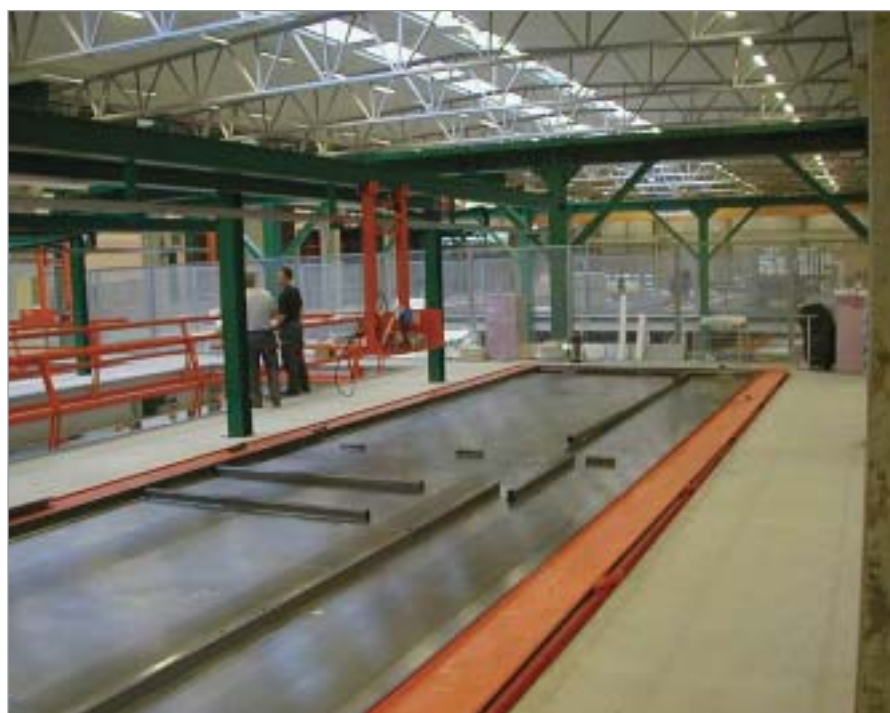
Die manuellen Schalplätze
