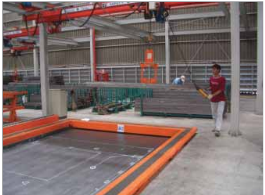
Schalungsbereich (Platzierung der Formen)
