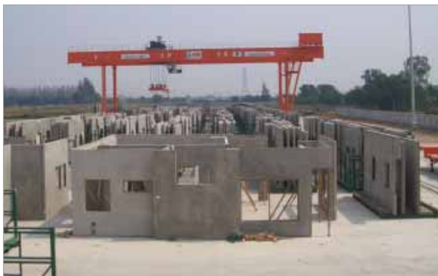
Portalkran und Lagerplatz
