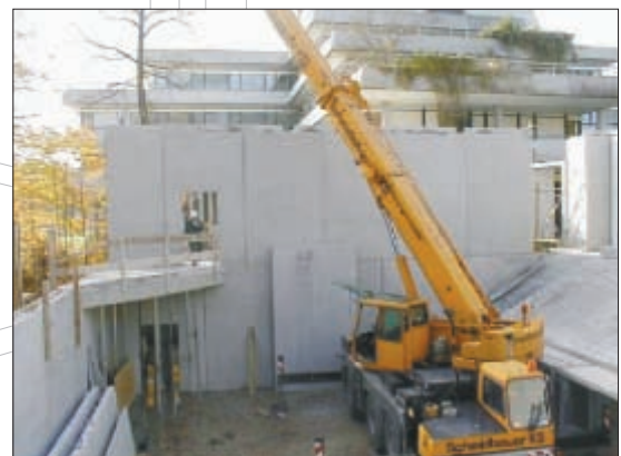
Montage von 10 m hohen SysproPART-thermo Wandelementen an der Universität Ulm
