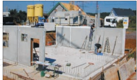
Kellerbau mit SysproPART-thermo Elementen
