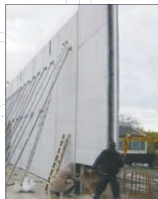
Montage von 10 m hohen SysproPART-thermo Wandelementen an der Universität Ulm
