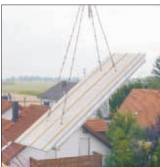
Montage eines Syspro Thermo-daches
